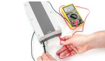
Spanning op de batterij controleren
